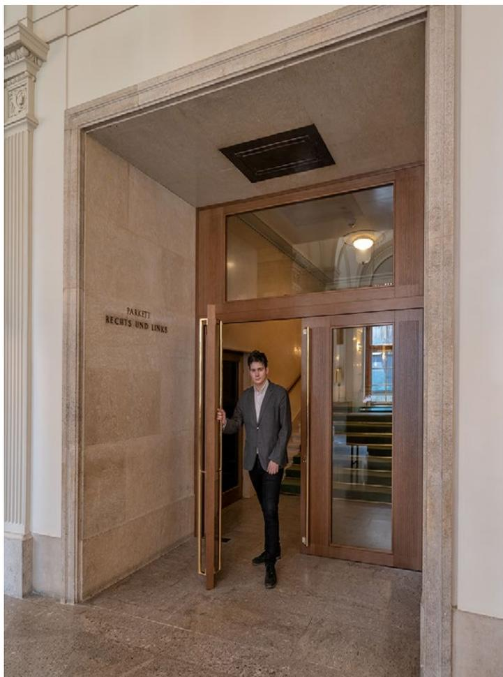
Ausgeführt wurden vier Pendeltüren in Rahmenbauweise Eiche massiv, drei davon mit einer Überhöhe von 3150 mm Durchgangslichte, ein weiteres Türelement mit festverglaster Oberlichte.
